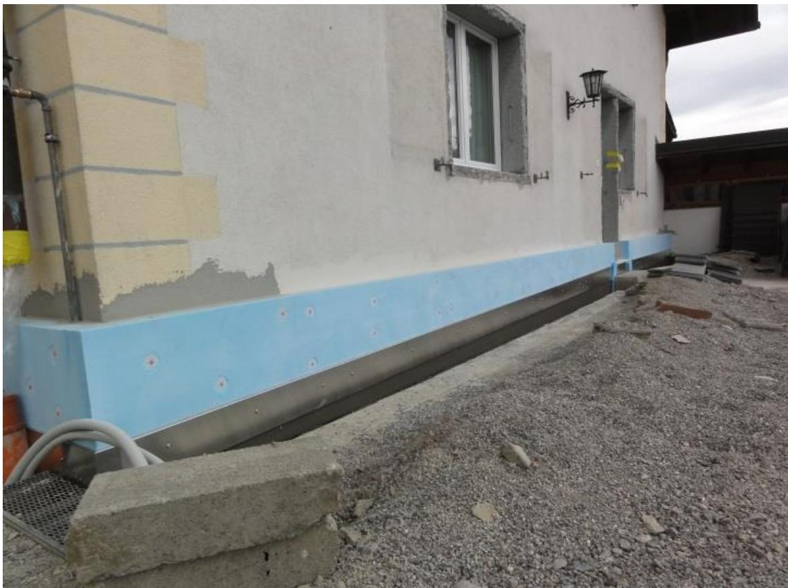
WDVS im Renovationsbereich. Anschluss an Terrain mit Dichtschlämme und Aluminiumsockel.
