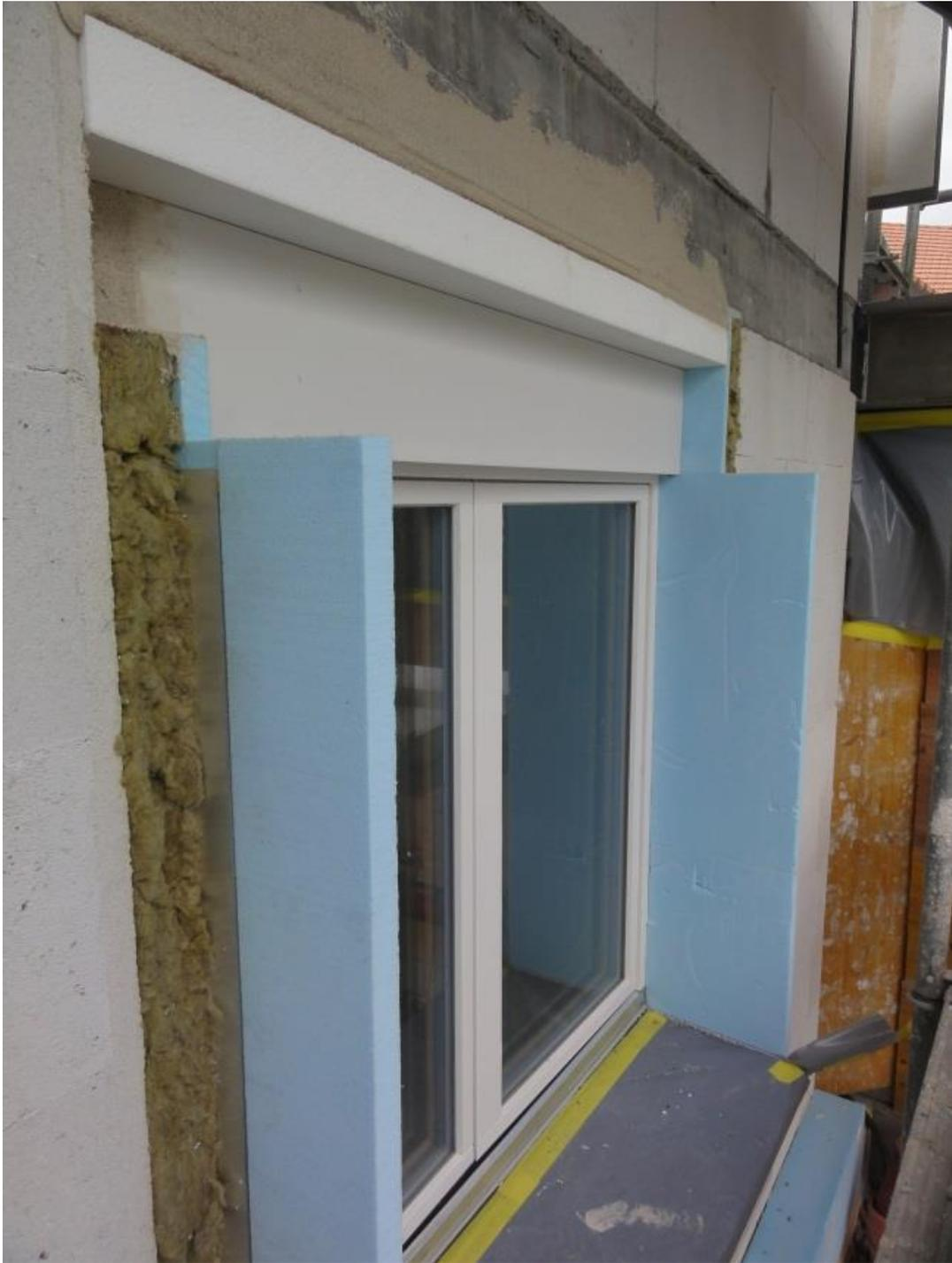
Technisch korrekt ausgeführte Isolation im Leibungs- und Sturzbereich mit vorfabrizierten Elementen.
